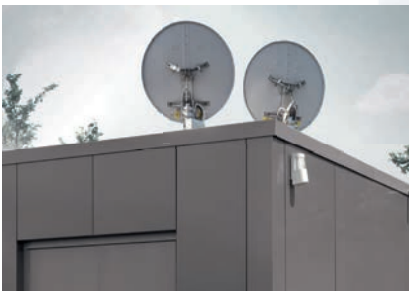
Mit montierter Richtfunkantenne
